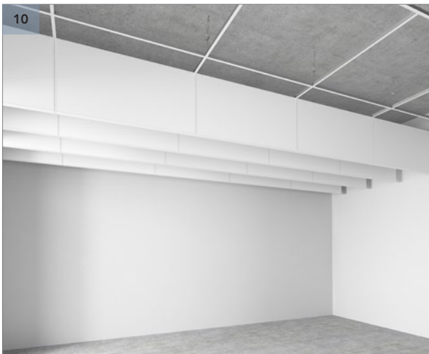
Fixer les baffles Rockfon Universal restants sur l'ossature T24 et les aligner grâce au tenon et mortaise à l'extrémité du baffle.
